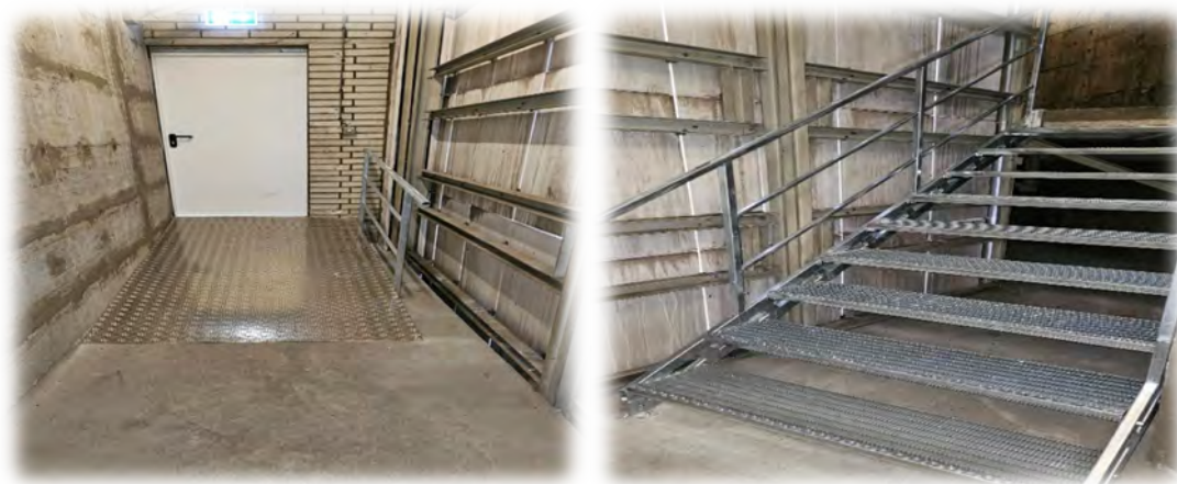
Evakuacijsko stopnišče iz 5. nadstropja
